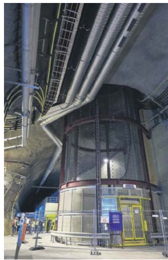
Schacht I in Sedrun: 800 Meter tief.
