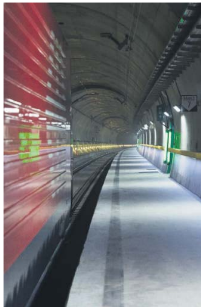
Richtungstrennte Einspurröhre West.
