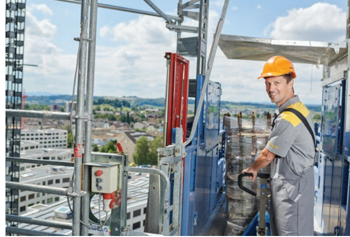
Grossbaustelle auf dem Suurstoffi-Areal in Rotkreuz: hier ein Baustellenlift im Einsatz
