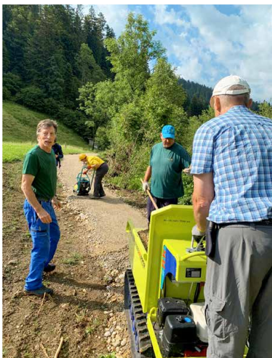
Willy Schwerzmann all'opera sotto la supervisione degli operatori del gruppo addetto al risanamento.
