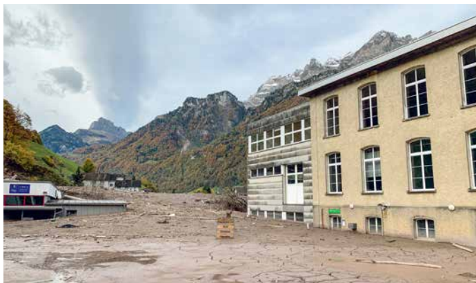
Le frane nel Cantone di Glarona hanno travolto molti edifici, tra cui l'ufficio di recapito di Schwanden.
