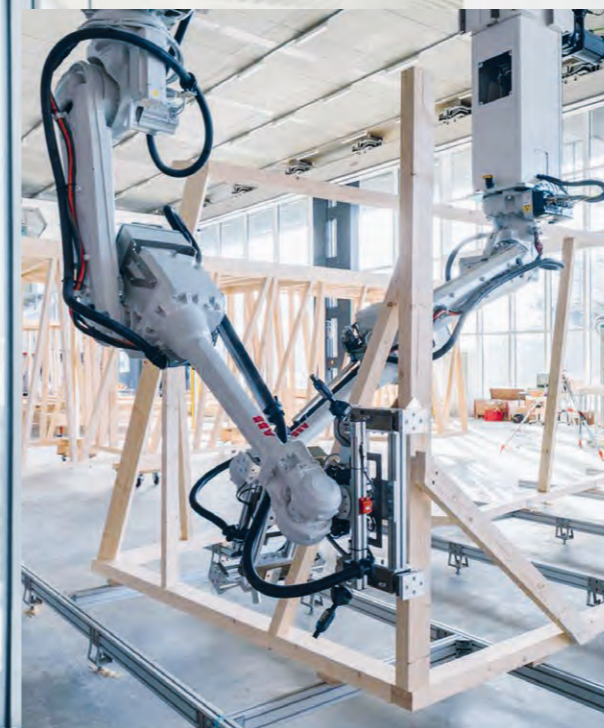
De la recherche à la pratique: c'est avec la DFAB HOUSE qu'a été appliqué pour la première fois un nouveau procédé numérique de construction en bois – les modules porteurs ont été préfabriqués par des robots. Même la fine dalle de béton a été réalisée à l'aide de technologies intelligentes. Elle a été coulée dans des coffrages imprimés en 3D.
