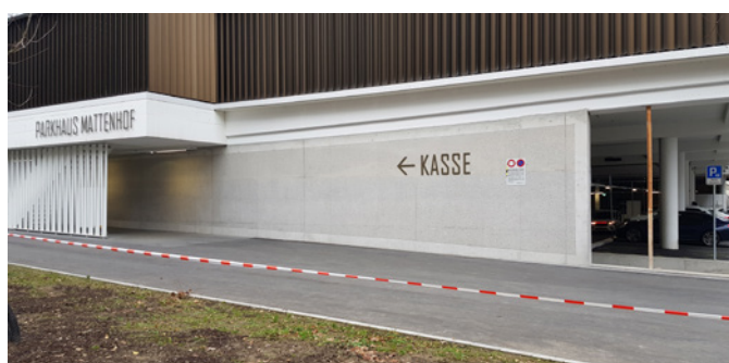
Entrée du «Parkhaus Mattenhof» (à pied vers l'escalier / l'ascenseur)
