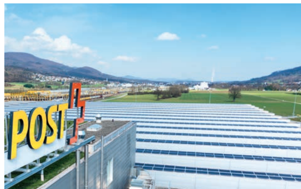
La Poste produit dans ses installations photovoltaïques de l'énergie solaire destinée à son propre usage. Le surplus est injecté dans le réseau public.
