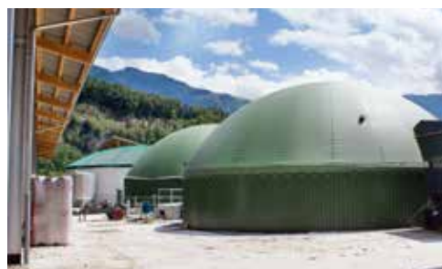
Elettricità ecologica dalle fattorie svizzere.
